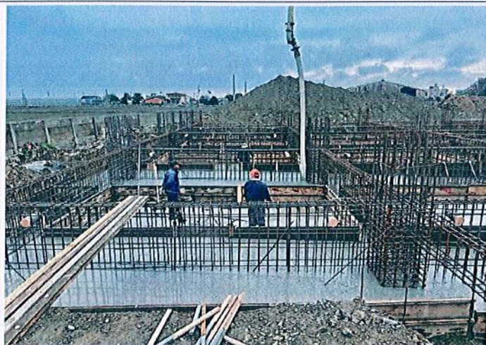
基礎混凝土澆置
